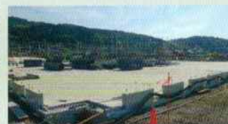
基礎コンクリ工事(健管棟)
